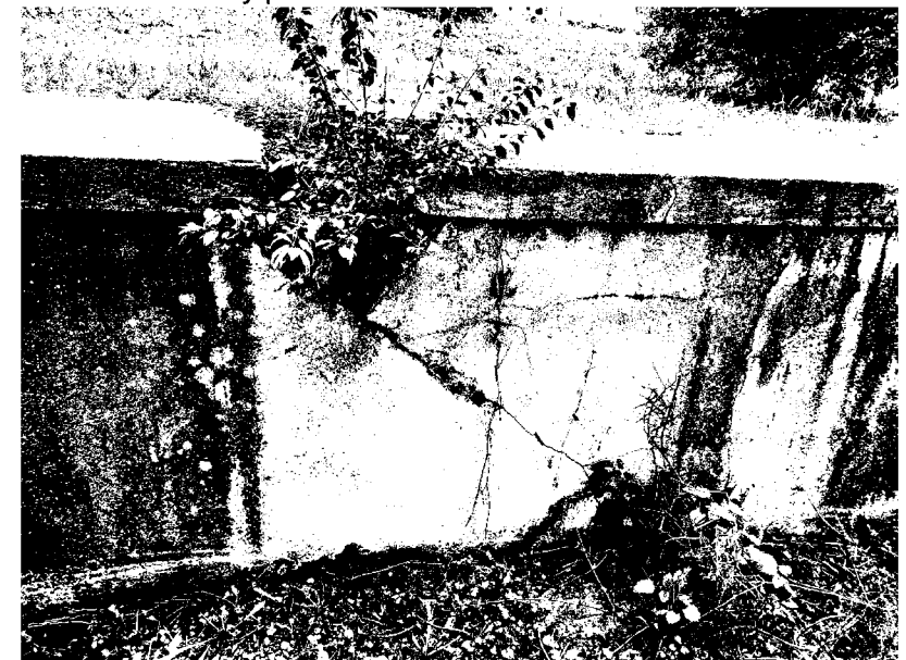
Foto 9 - šikmá trhлина skrz zeď s projevem úplného rozpadu betonu zdi do hloubky 15-30 cm
