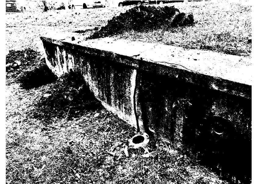
Foto 3 – Sonda SZ1 a vývrt V1, svislá trhлина skrz zeď
