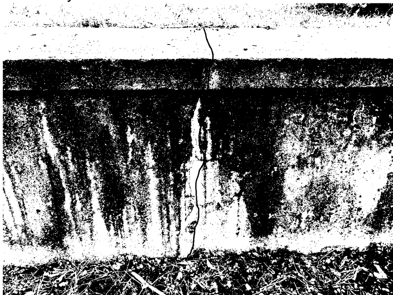
Foto 7 - svislá trhлина skrz zeď
