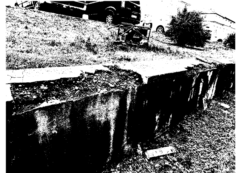
Foto 12 - úplný rozpad korouny zdi
