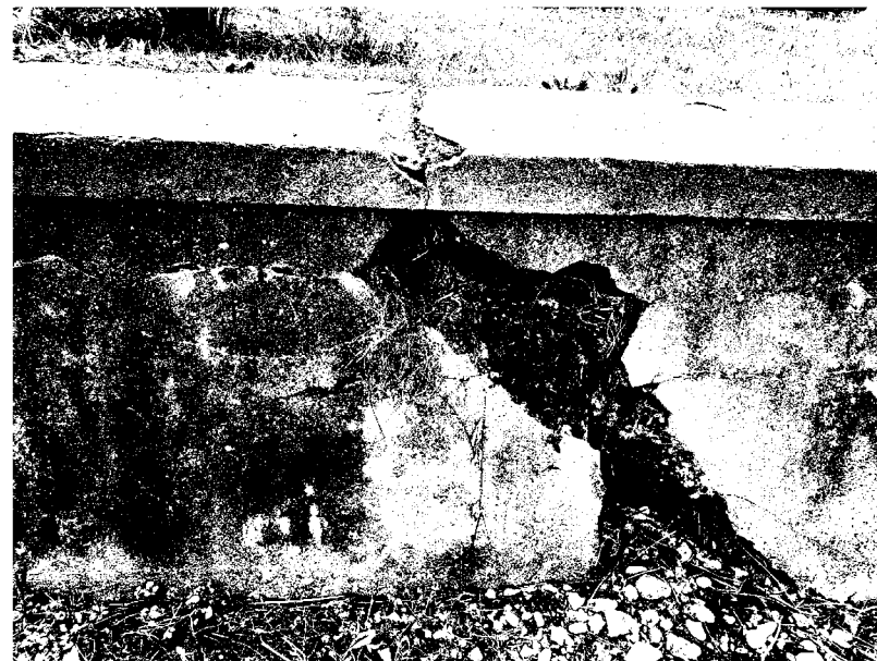
Foto 8 – šikmá trhлина skrz zeď s projevem úplného rozpadu betonu zdi do hloubky 15-30 cm
