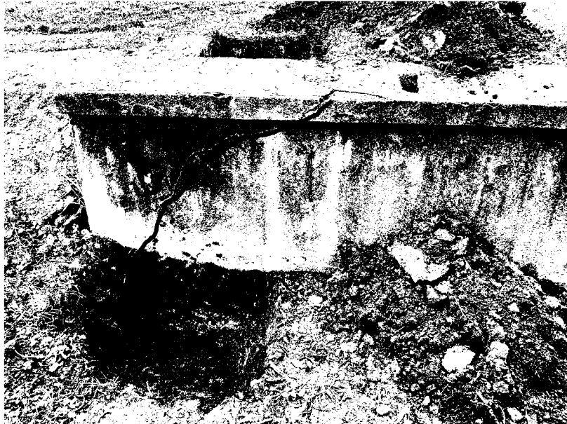
Foto 1 – Sonda SZ1 – sonda základ, šikmá trhлина skrz zeď
