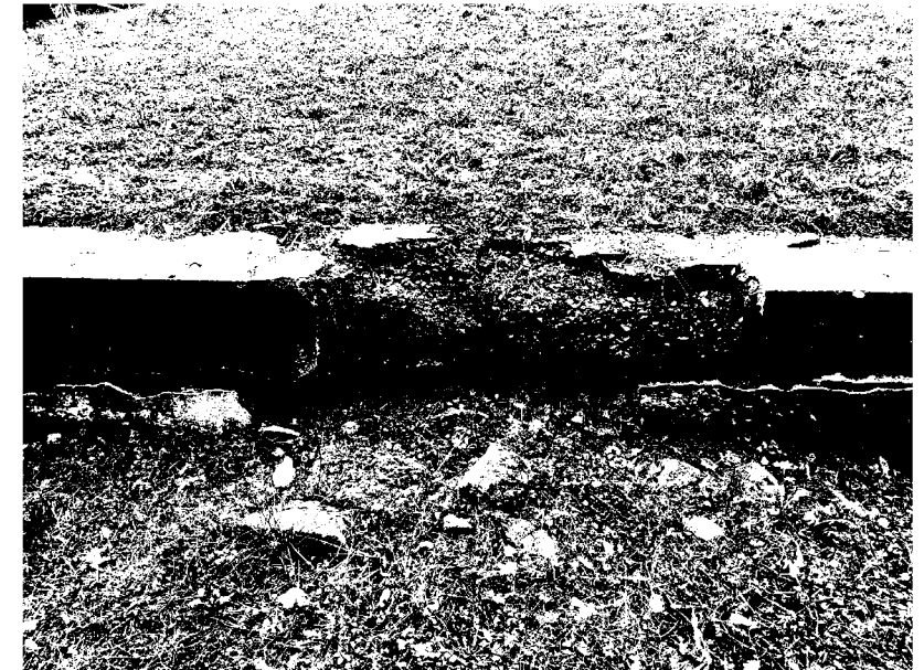
Foto 21 - úplný rozpad zdi v celé její šířce
