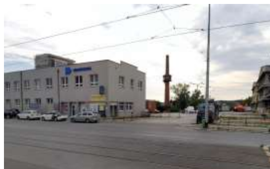
Fotografie industriálního komínu s vodojemem v areálu strojíren Praga zdroj: www.mapy.cz
