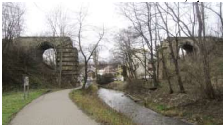
Fotografie torza železničního mostu po němž má vést (zprava) navrhovaná cyklostezka zdroj: www.mapy.cz
