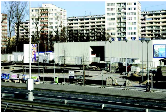
Stanice metra C Prosek - parková úprava povrchu
