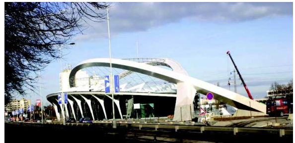
Stanice metra C Střížkov
