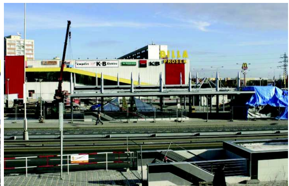
Stanice metra C Prosek
