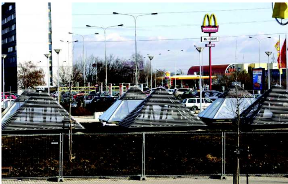
Stanice metra C Prosek - skleněnými jehlany proniká denní světlo
