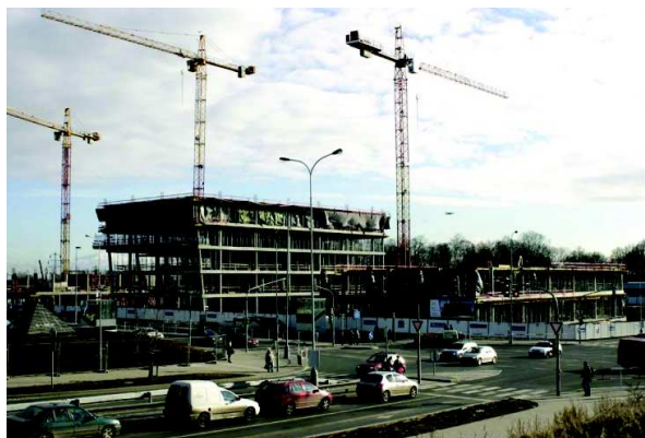
Stavba administrativního komplexu Prosek Point
