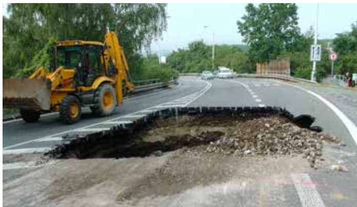
Propad o velikosti 4x8 metrů způsobil stejně jako v srpnu 2012 po přivalových srážkách havárie kanalizační stoky
