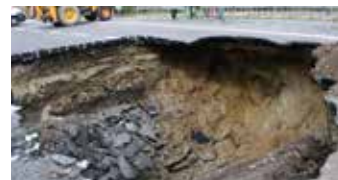
Propad o velikosti 4x8 metrů způsobil stejně jako v srpnu 2012 po přivalových srážkách havárie kanalizační stoky
