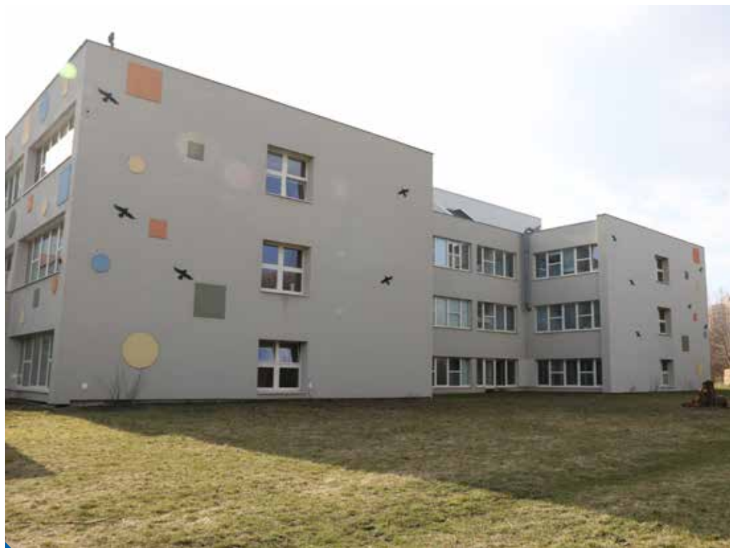
Severovýchodní část Polikliniky Prosek, kde je plánována přístavba pavilonu H
