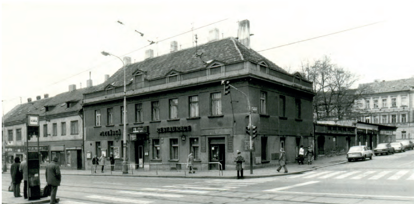
Hostinec U Lípy na rohu ulic Sokolovská a Krátkého před demolicí
