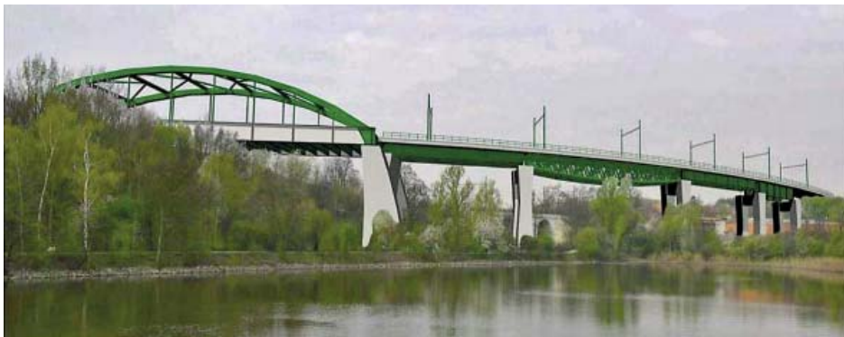
Nová stavba dvoukolejného mimoúrovňového křížení trati z Libně nad kolejemi trati Kolín – Praha-Libeň
