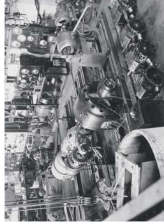
Vpředu motory pro pražské trolejbusy, za nimi zařízení generátor pohonu elektrického přenosu Slovenské strelky na zkušebně
