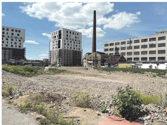
Místo u stanice metra Kolbenova, kde vznikne nové komunitní centrum s venkovním hřištěm na parkour, pumptrackovou dráhou i komunitní zahrádkou
