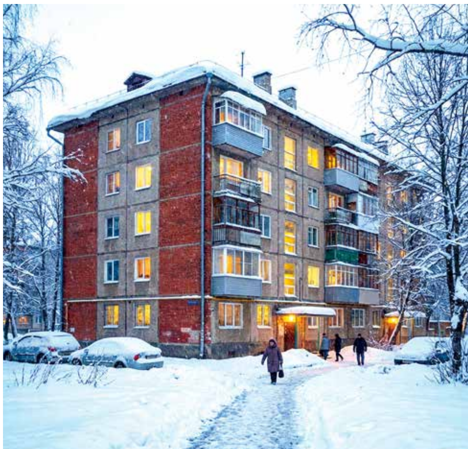
Tepelné čerpadlo do rodinného nízkoemisního domu s topením v podlaze je dobrá věc. Ale tepelné čerpadlo do panelového nebo bytového domu je poměrně velká komplikace.
