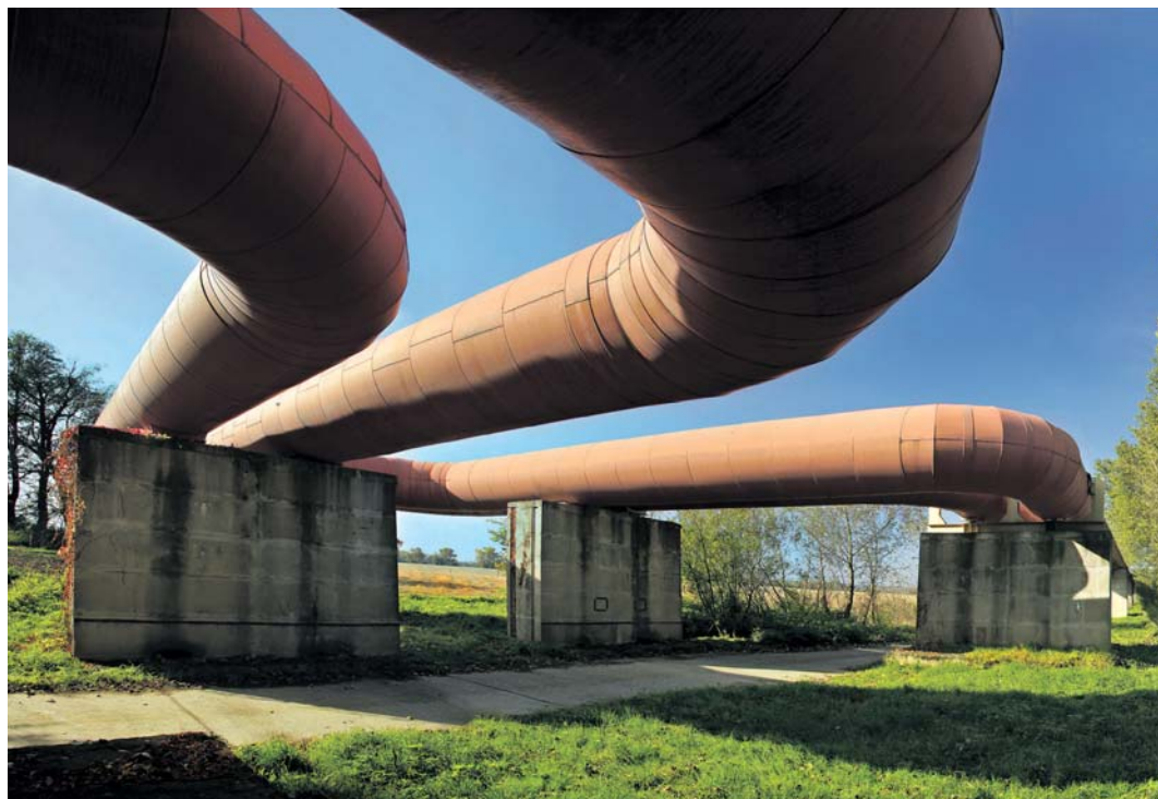
Teplo proudí do Prahy z Mělníka mohutným napáječem.
