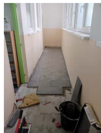
Výměna dlažeb a obkladů v Mateřské škole Novoborská
