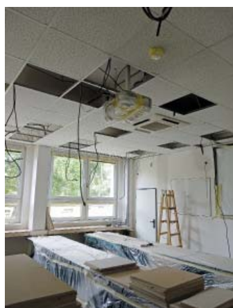
Rekonstrukce elektroinstalace v ZŠ Litvínovská 600
