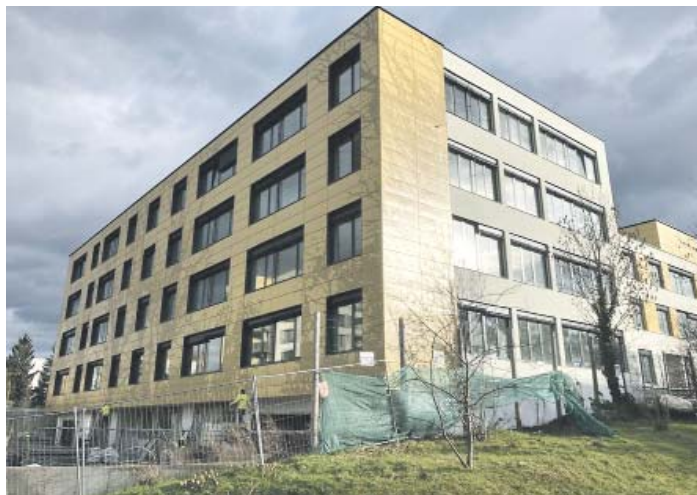
Novou budovu Základní a mateřské školy Elektra čeká kolaudace v polovině letošního roku
