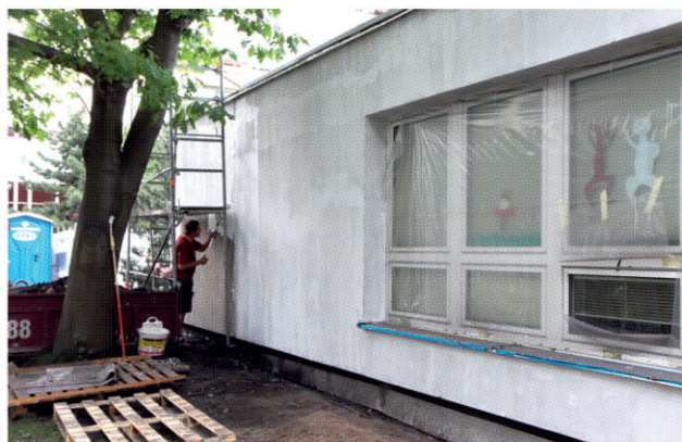
Přes léto finišují práce na zateplování čtyř mateřských škol na „devítce“. Naše fotografie je z MŠ Veltruská.
