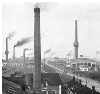
Spalovna ve Vysočanech (30. léta 20. stol.)
