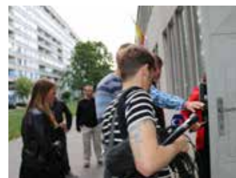
Začátek desinfekce vodovodního potrubí pod dozorem novinářů
