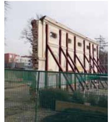
Po zbourání zdí, které hrozily zřícením, zůstala z bývalého hostince U Brabců jen štítová zeď
