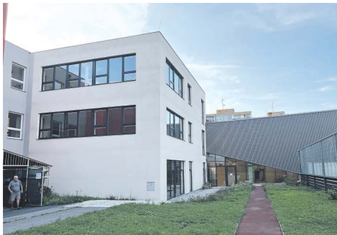
Přístavba s novými třídami a nová sportovní hala je pomyslnou tečkou za rekonstrukcí školního areálu ZŠ a MŠ Na Balabence, která probíhala od roku 2018
