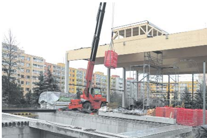
V ZŠ a MŠ Na Balabence roste sportovní hala
