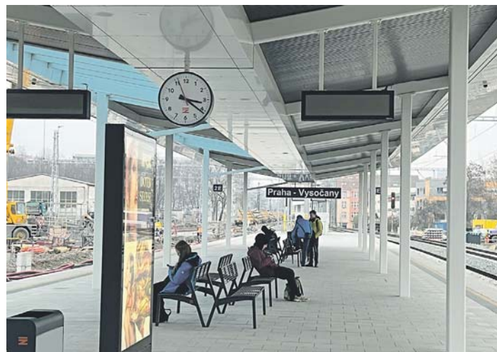
Nové bezbariérové nástupiště ve stanici Praha-Vysočany
