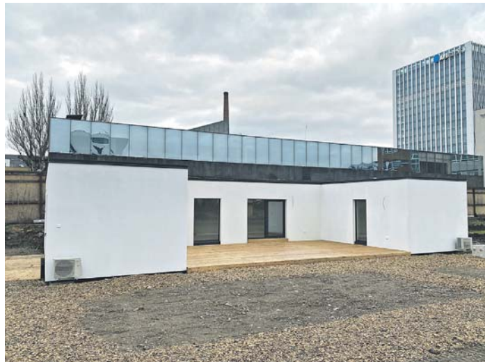
Nové komunitní centrum v Kolbenově ulici vybudovala společnost Skanska
