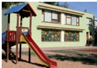
Výstavba nového pavilonu přišla na více než dvacet milionů korun
